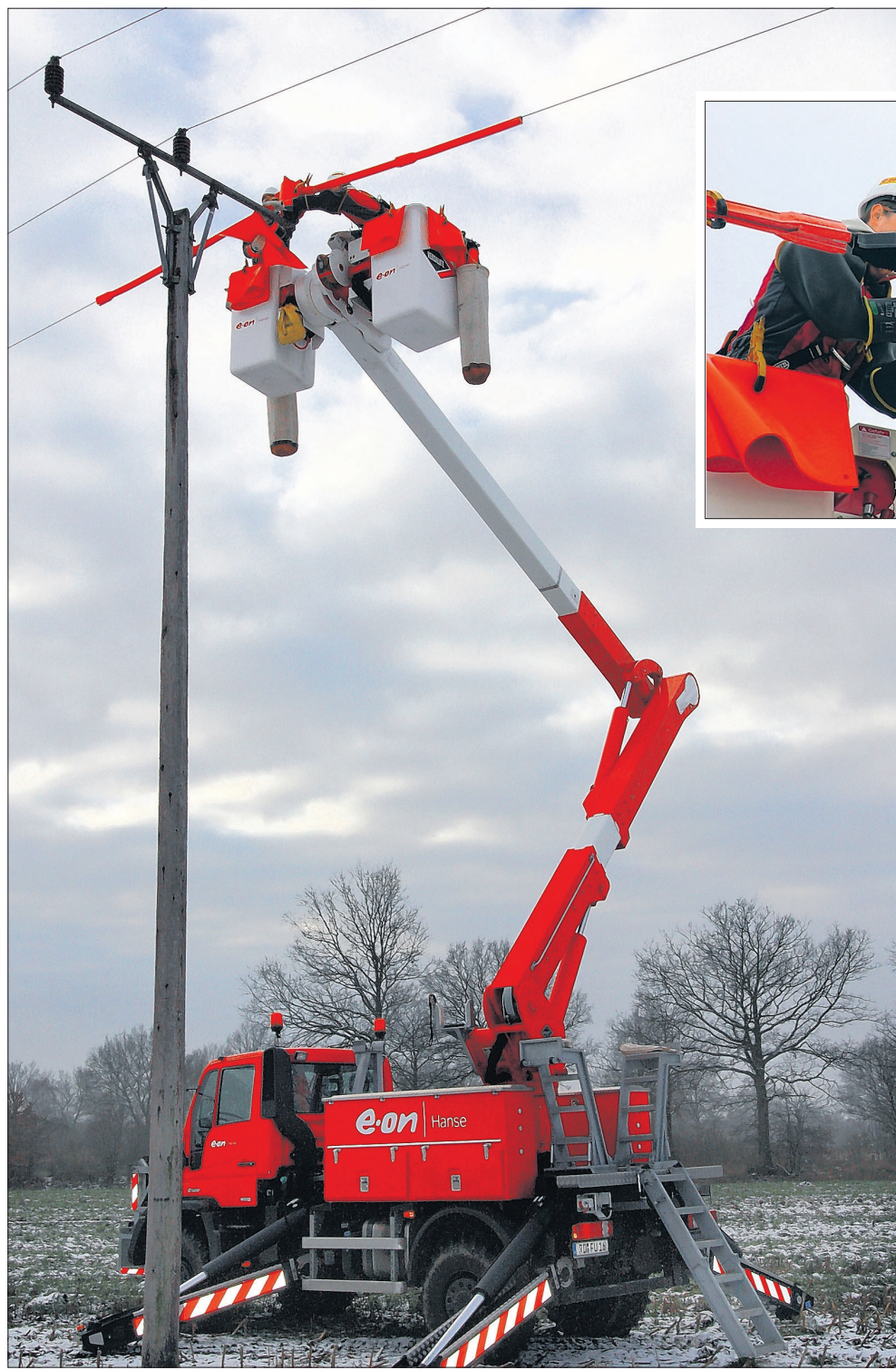
Aus nicht-leitender Glasfaser bestehen der Hubarm und die Arbeitsbühne. Sie sorgen dafür, dass die Männer arbeiten können, ohne dass der Strom abgeschaltet werden muss.
